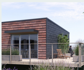
ENF04 KLIMAKASSEN OPFØRT I 2022 86 m 2 1 ETAGE 2 BEBOERE
