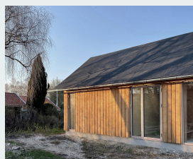
ENF09 (ENFAMILIEHUS) PRAMVEJEN UNDER OPFØRELSE (2023) 122 M 2 1 ETAGE 4 BEBOERE
